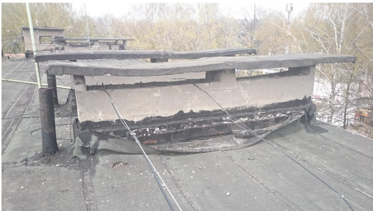
Фото 6 Надстройка над люком выхода на кровлю
