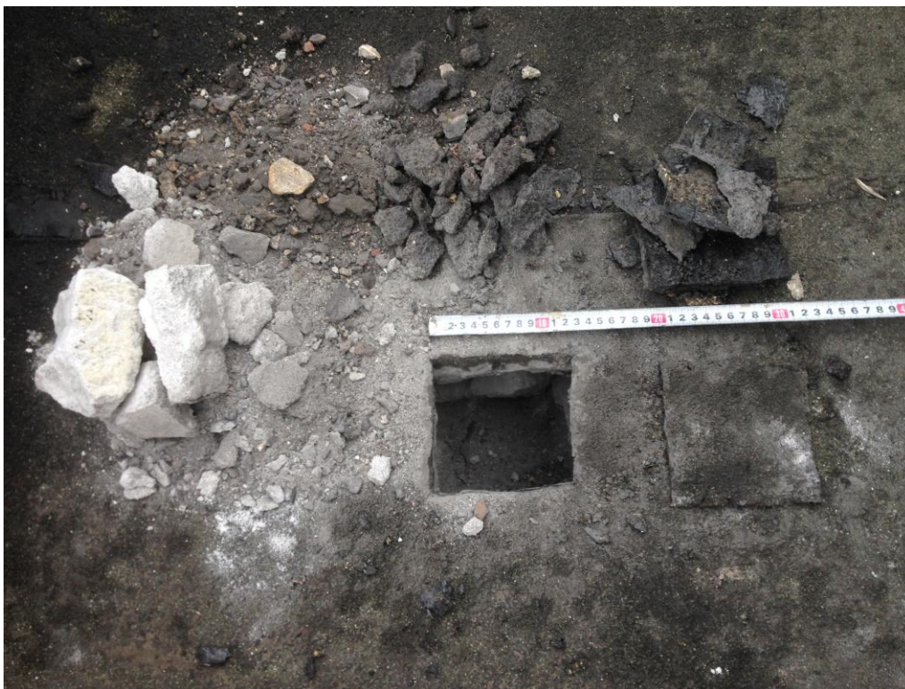
Фото 8 Состав кровли (шурф) .
