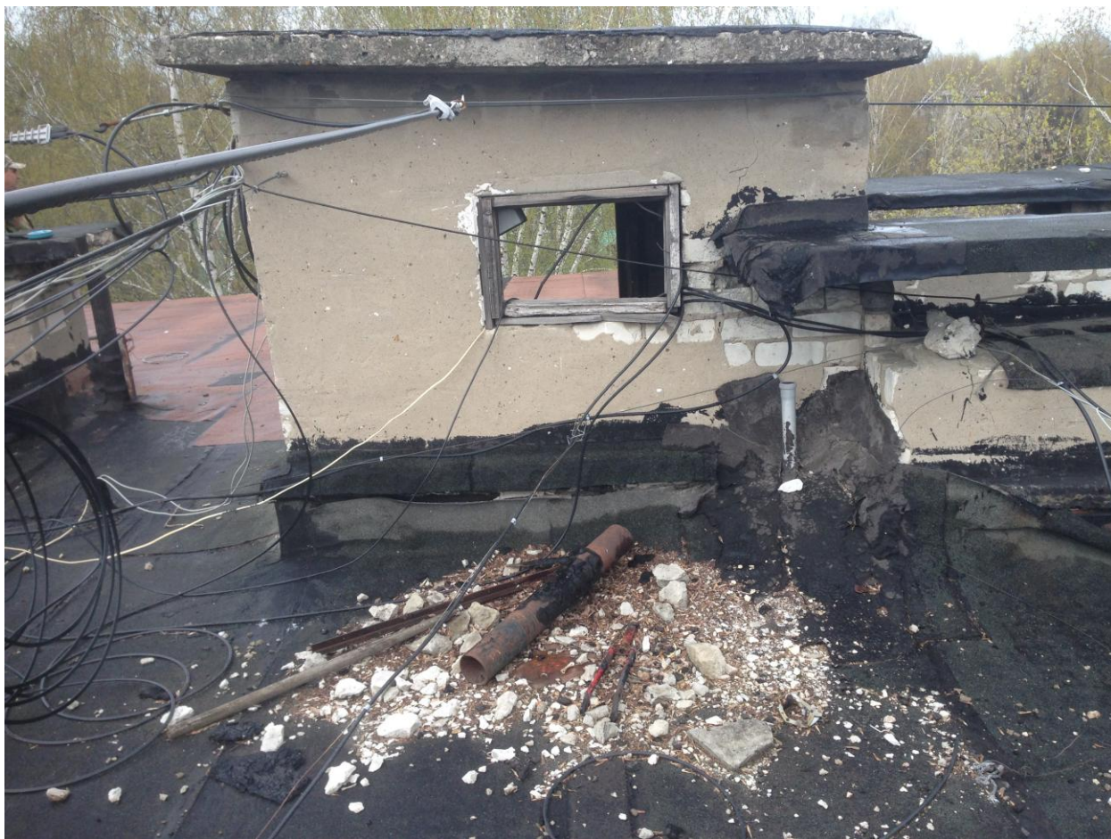
Фото 7 Состав кровли (шурф)
